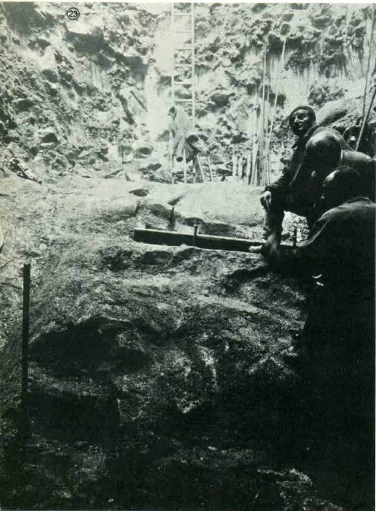
L'interno dello scavo della pila n° 3; in questo caso è stato raggiunto il banco roccioso. La profondità massima dello scavo è stata di 17,30m
